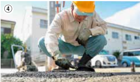
①1件ずつ対応を検討していく②現場で図面との照合や幅員の計測もする③道路側溝のふたの交換などは手持ちの資材ですぐに対応できるか在庫を確認する④アスファルト合材を機械でならす前にスコップで伸ばして整える⑤通行量の多い道路の舗修は、周囲の車の状況を見ながら手早く対応する
