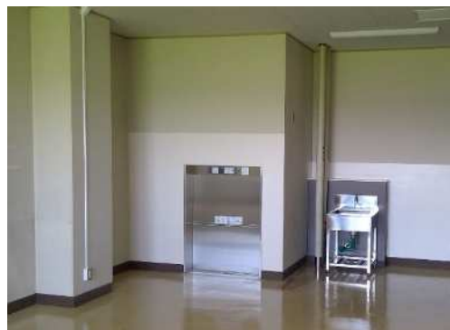
令和5年度整備した中学校の受入室
