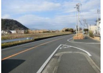
花水川左岸堤防
