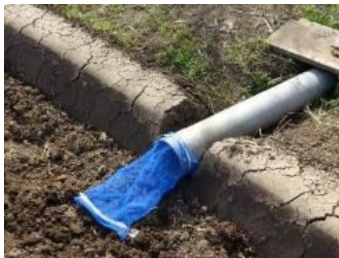
取水口への網の設置
