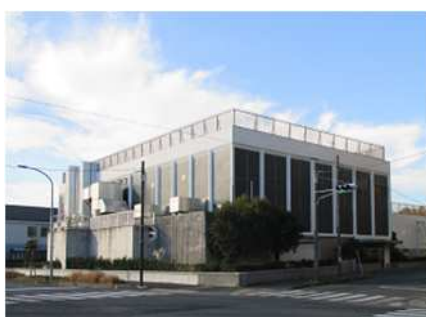
東部ポンプ場
