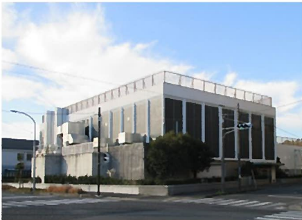
東部ポンプ場
