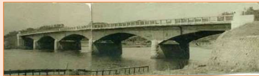
【建設当時の花水川橋】
