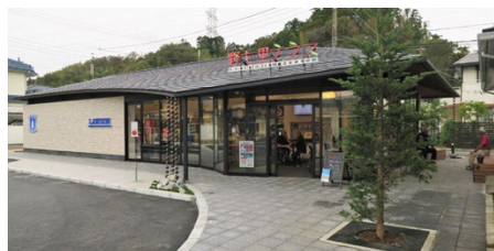
野七里テラス外観
