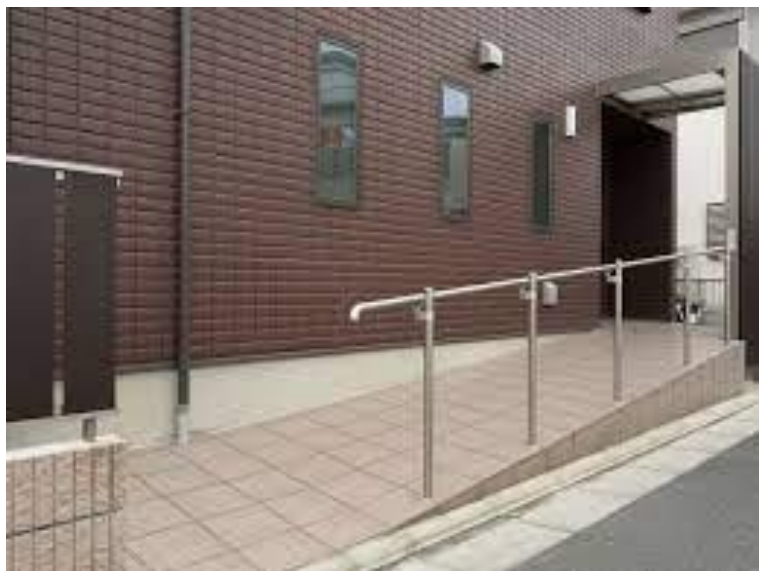
車椅子用スロープ
