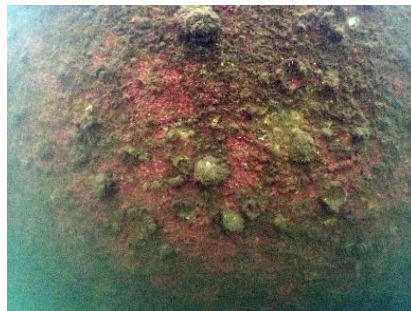
Fig.10 調査箇所③状況
