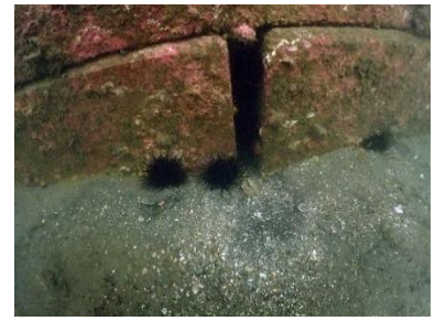
Fig.8 調査箇所②状況
