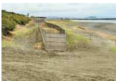
竹柵の陸側に、新たに園路工事する
