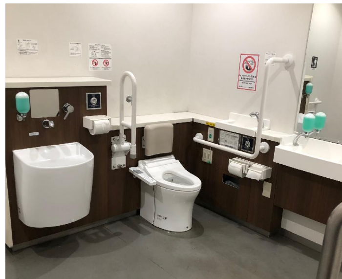
多目的トイレ
