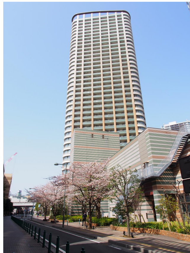
タワーマンション (武蔵小杉)
