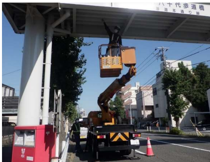
写真6－1 横断歩道橋の点検状況
