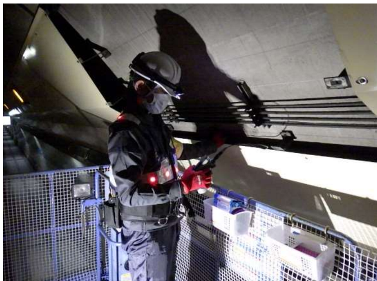
写真6－1 道路トンネルの点検状況
