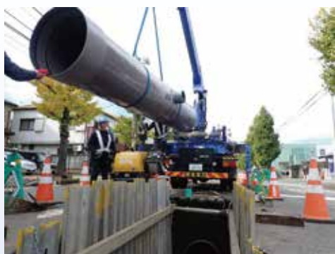
雨水管の新設（立野町）
