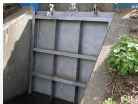
河川への放流ゲート改修（御殿3丁目）
