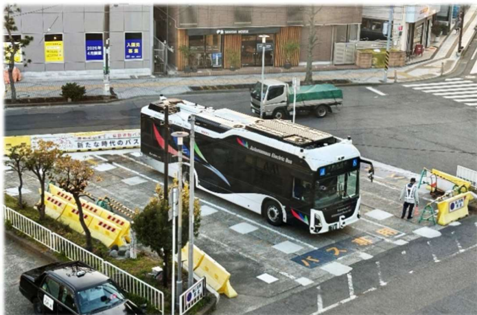
平塚駅南口駅前ロータリー内の自動運転バス待機場 (令和6年度暫定整備)
