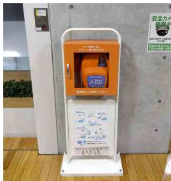
収納ボックス (市役所本館)
