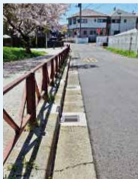
落ち葉対策用の蓋に改修した雨水柵
