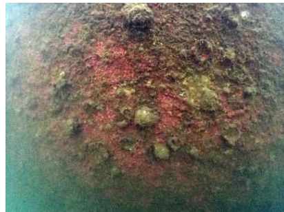
図12 調査箇所③状況
