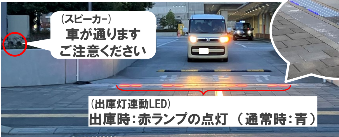
安全横断補助システム 設置の様子
