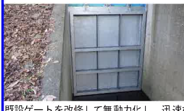
ゲート改修（南原、山下）⇒令和3年度完成
