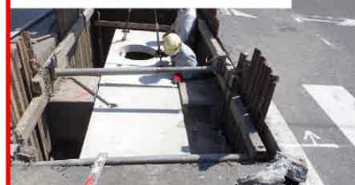
管路整備（東豊田）⇒令和3年度完成
