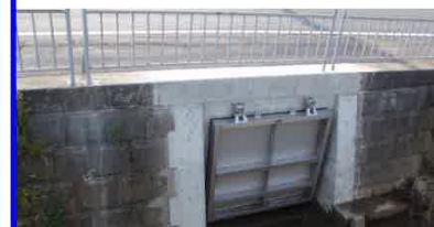
ゲート整備（豊田打間木）⇒平成28年度完成
