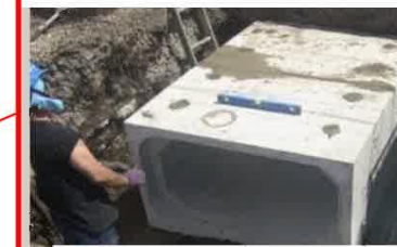
管路整備（真土、横内）⇒令和5年度完成
