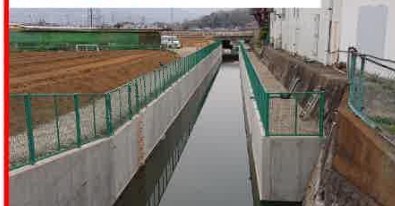
排水路整備（岡崎）⇒令和2年度完成
