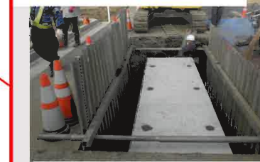
管路整備（須賀）⇒平成28年度完成
