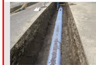
管路整備（達上ヶ丘）⇒令和3年度完成
