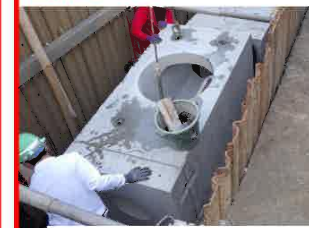
管路整備（新町）⇒平成30年度完成
