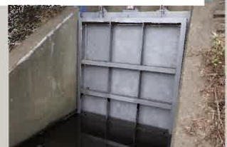
ゲート改修（御殿）⇒令和4年度完成
