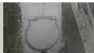
ゲート整備（中原、東中原）⇒令和元年度完成
