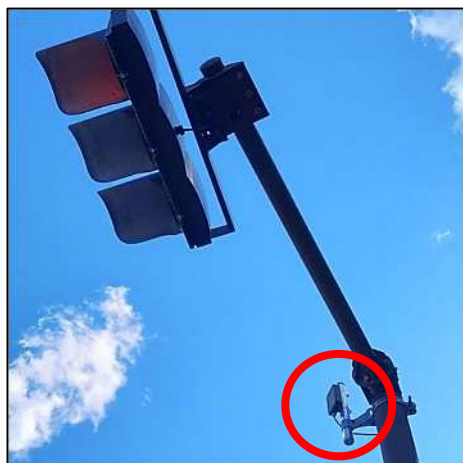
(平塚市役所前交差点 信号機付近)
