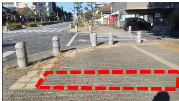
横断歩道への視覚障害者用誘導ブロック設置が必要な箇所 (生活関連経路5 県道 608 号)
